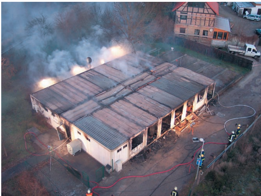
Blick auf die Container-Wohnanlage. Besonders gut sind die vier quer zu den Wohncontainern aufgestellten Container zu erkennen, die als Mittelflur genutzt worden sind.
